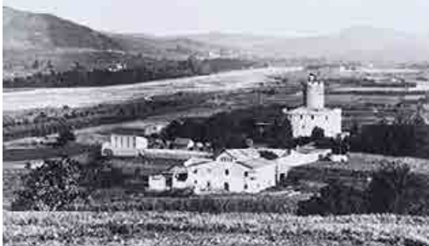
E. G. S. - S. Sta. Coloma de Gramenet Torre Sagarra y Casa Jové
